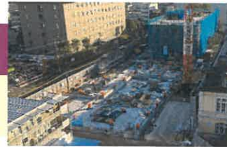
(工事の状況(令和4年1月現在))
