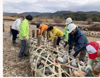
竹蛇籠の設置作業 (木津川)
