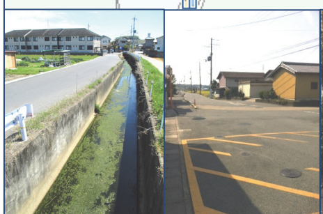
⑮夜間走行注意 水路へ転落危険
