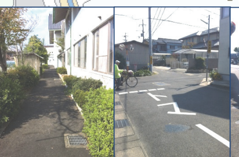
⑮夜間走行注意 水路へ転落危険
